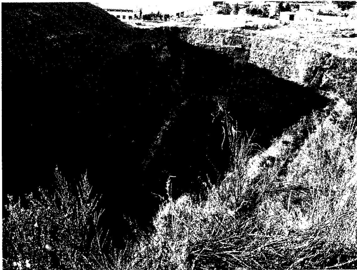
*Foto 11 – Depressione ad est della discarica: si notino le fessure verticali nei terreni in posto.*
